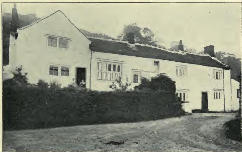
Fig. 61.—BANK HOUSE, SALTERHEBBLE.
